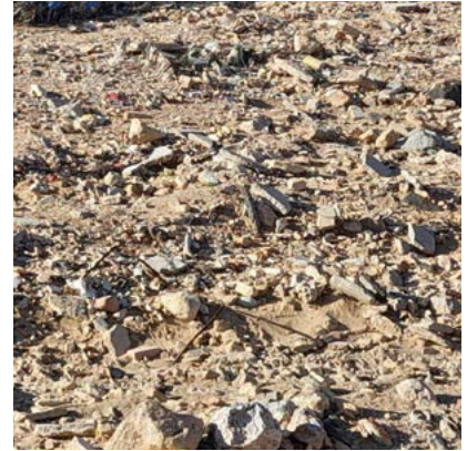
Acumulación de basuras y escombros en el cauce.
